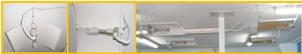
Fig. 2.14. Sistemul de iluminat: 4 lămpi metal - halide (MH) pentru vegetație, tip MAX – LUMENS (foto. original)
