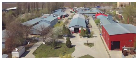
Figura 2.1. Facilitățile SetCar S.A. Brăila destinate depozitării temporare a deșeurilor chimice periculoase – vedere de ansamblu (sursă: galerie foto SetCar S.A. Brăila)
